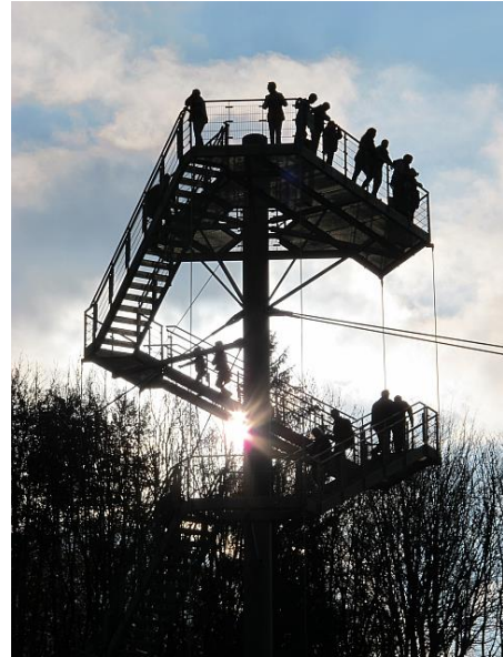
„Flussraum Iller“ bei Legau im Illerwinkel - Aussichtsplattform
